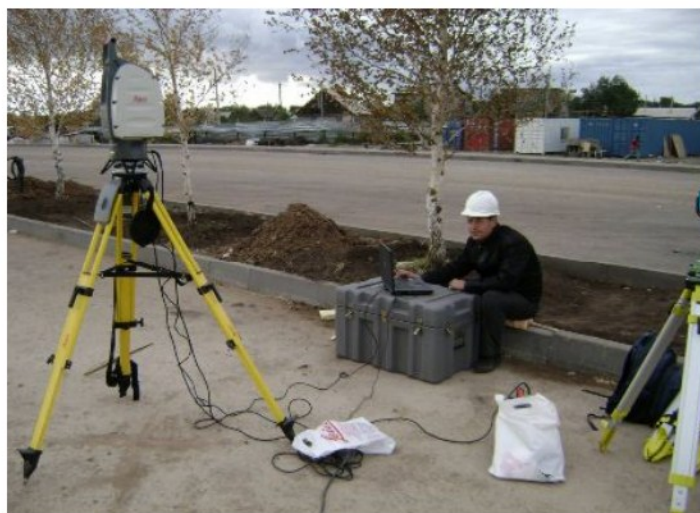
Рис.6. Лазерный сканер в процессе работы
